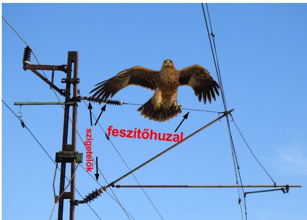
6. ábra: Feszítőhuzal, vagy feszítő sodrony és hosszabb szigetelő alkalmazása esetén azonban lényegesen csökken az esélye nagytestű madarak áramütésének. A huzalra (sodrony) nem szívesen ül nagy testű madár
