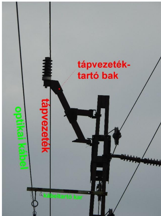
9. ábra: A fázispotenciálú tápvezeték, valamint a földpotenciálú szerkezeti elemek, mint a tápvezeték tartóbak, oszlop, kábeltartó kar. Az oszlopcsúcsra kiülő madár a leszálláskor és elrugaszkodáskor is könnyen hozzáérhet a tápvezetékhez
