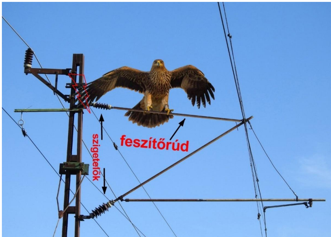
5. ábra: A feszítőrúdra kiülő nagytestű ragadozómadár a méretei miatt könnyen rövidre zárhatja az áramkört
