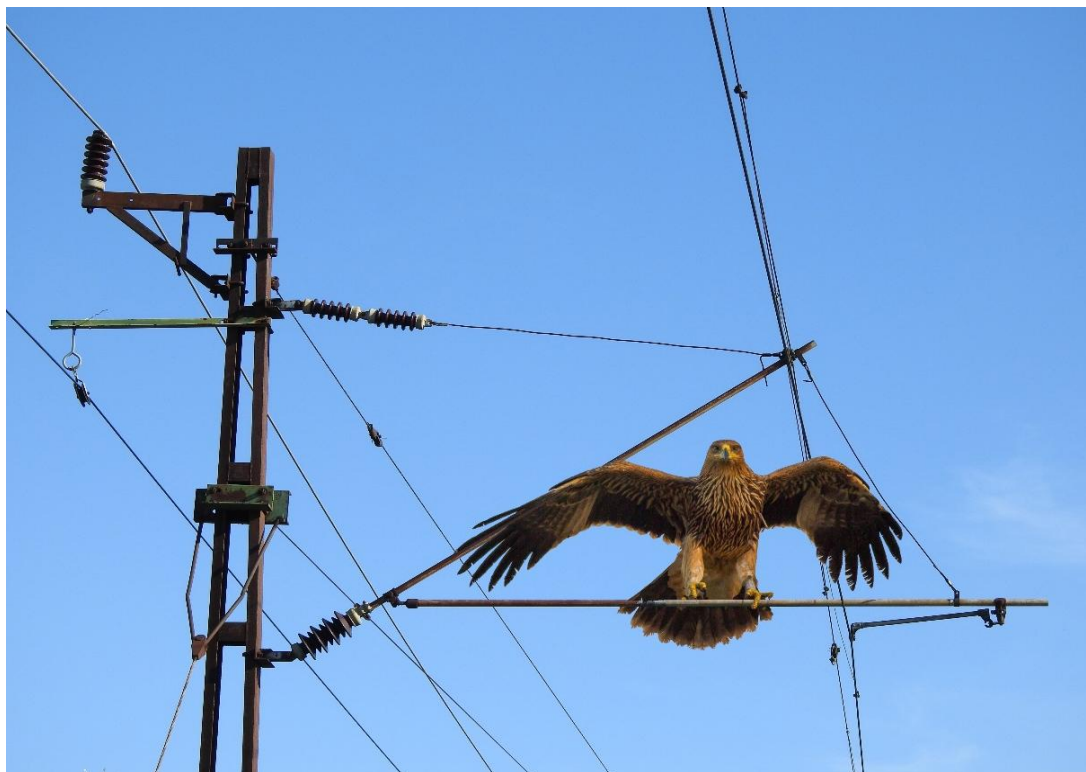
13. ábra: A főkar, a feszítőhuzal (sodrony), továbbá a válaszszigetelők hosszmérete madárvédelmi szempontból is elfogadható távolságot biztosít a fázis és földpotenciálú szerkezeti részek között
