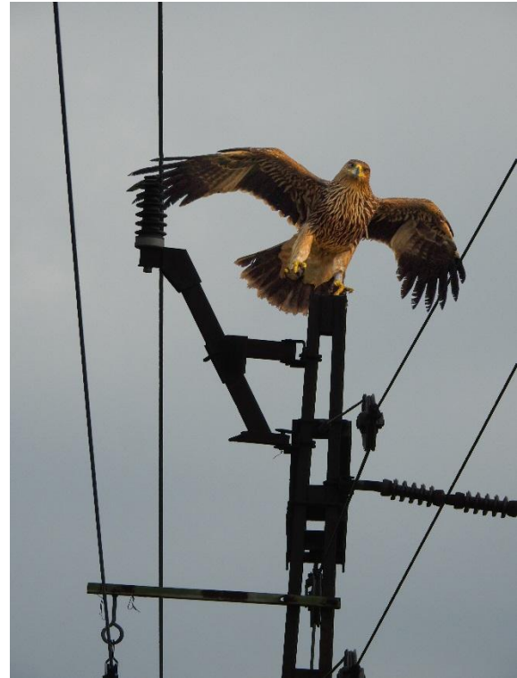
9. ábra: A fázispotenciálú tápvezeték, valamint a földpotenciálú szerkezeti elemek, mint a tápvezeték tartóbak, oszlop, kábeltartó kar. Az oszlopcsúcsra kiülő madár a leszálláskor és elrugaszkodáskor is könnyen hozzáérhet a tápvezetékhez
