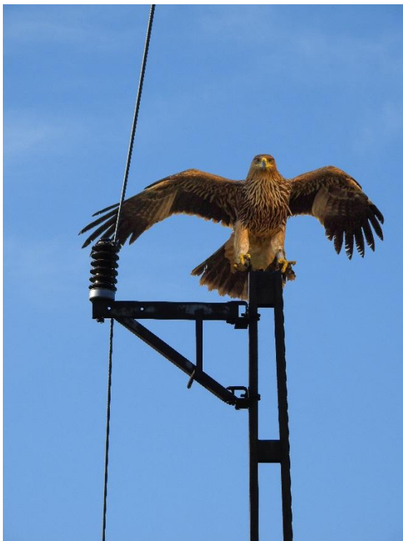
10. ábra: Az oszlopcsúcsra, vagy a tápvezeték tartóbakra kiülő madár a leszálláskor és elrugaszkodáskor is könnyen hozzáérhet a tápvezetékhez
